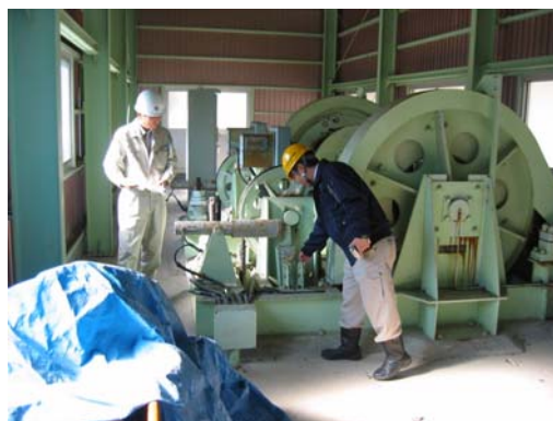
笹生川 ダムゲート巻上げ機点検 (大野市本戸)
