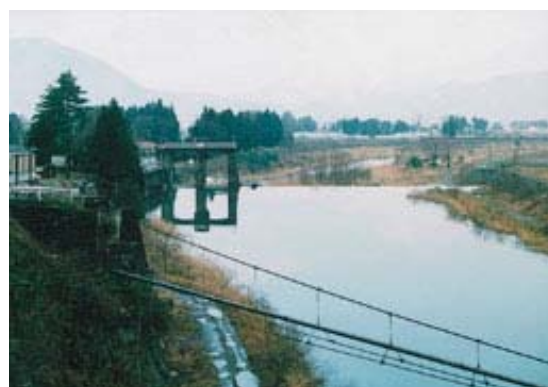
真名川用水頭首工（大野市五条方）
