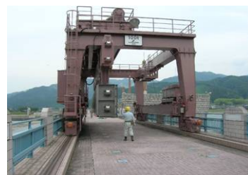
堰ゲート設備点検
