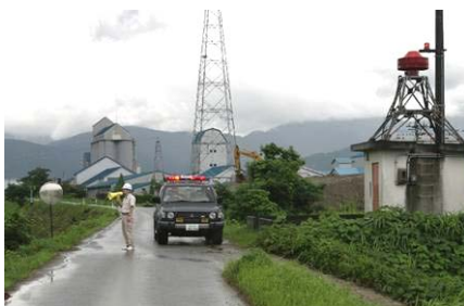
放流警報局と河川巡視
