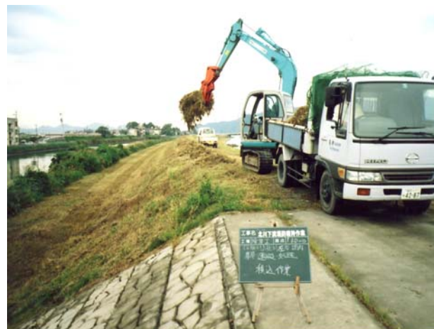
写真 4.2 除草後の積み込み作業
