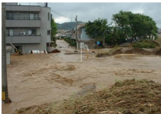
平成 16 年 7 月洪水（福井豪雨） 足羽川の堤防が破堤（福井市春日）
