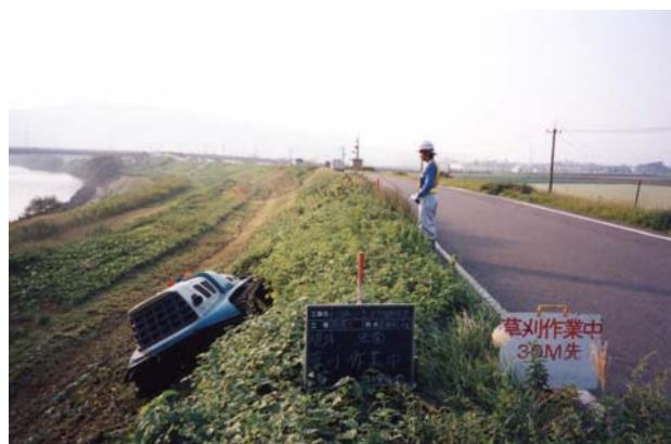
写真 4.1 出水期、台風期前に堤防等の除草を実施
