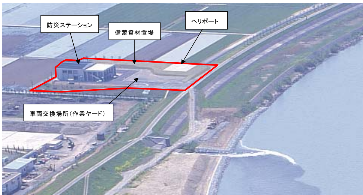
写真 2.4 九頭竜川土橋地区河川防災ステーション
