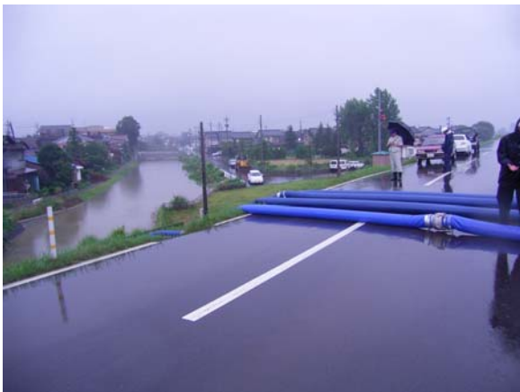
写真 2.3 芳野川における排水ポンプ車等による緊急排水状況
