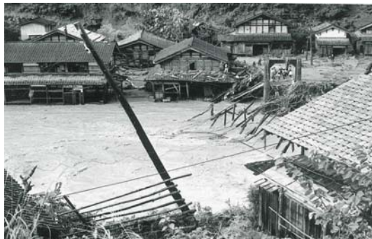
昭和 40 年 9 月洪水（奥越豪雨） 西谷村（現大野市）の被災状況
