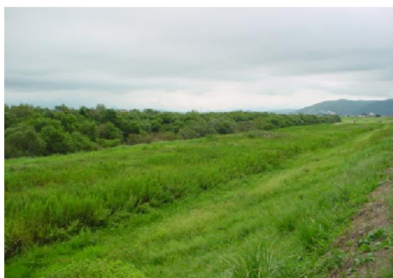
樹林化によって川面が見られない
