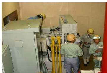
電気設備点検
