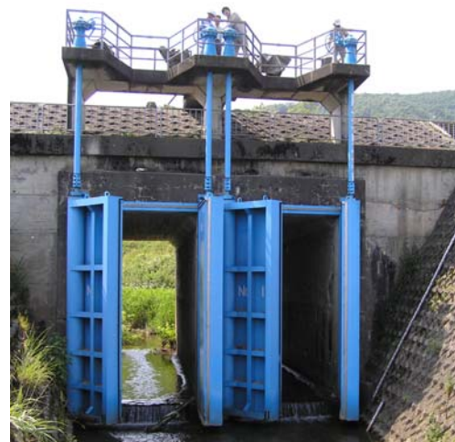
写真 4.3 樋門の点検・整備
