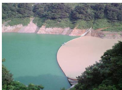
汚濁防止フェンス設置
