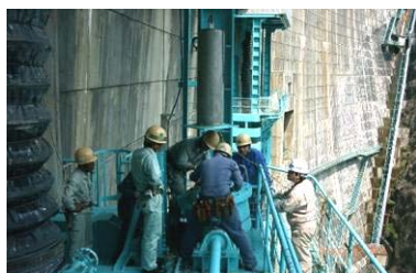
ダム放流設備点検
