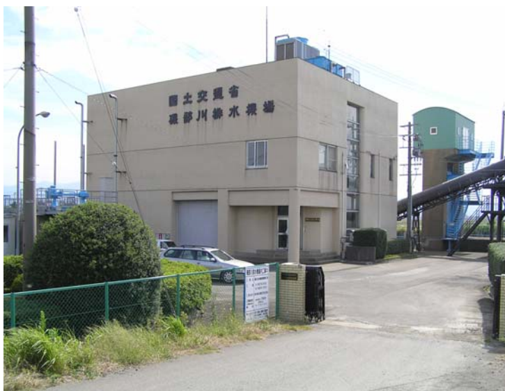
写真 3.6 磯部川排水機場
