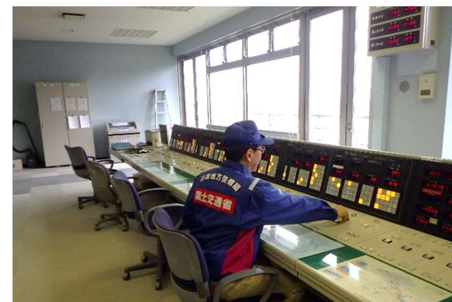
堰の操作システムの点検の様子
