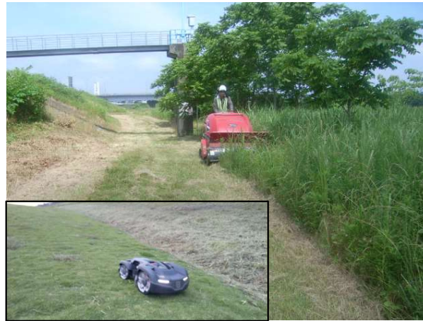
(堤防除草(自動草刈機の試行)) 新技術: Automower (NETIS:KT-200061-A)
