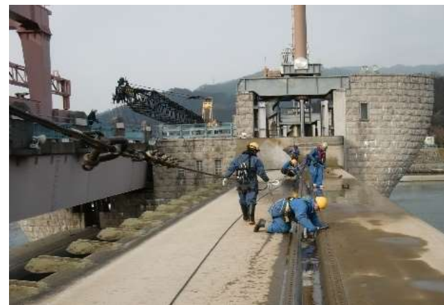
主ゲート扉体点検の様子
