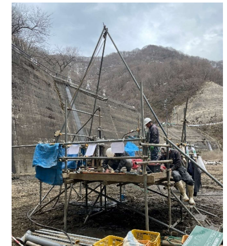
地質調査の状況（令和5年撮影）
