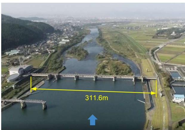
九頭竜川鳴鹿大堰(下流を望む)
