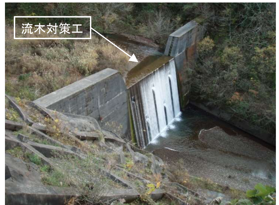
巢原川堰堤改築(流木対策工)
