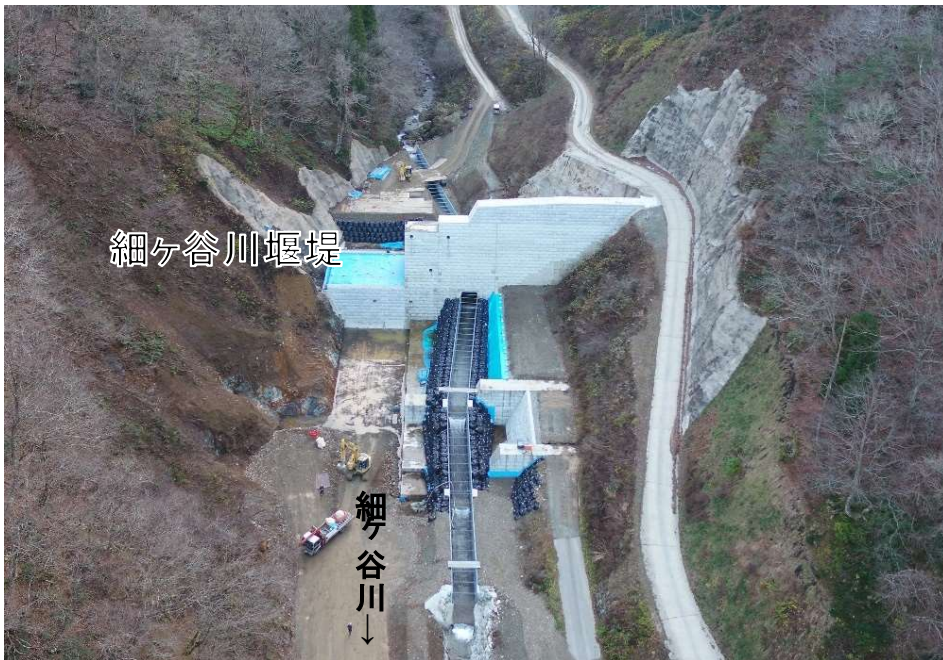
細ヶ谷川堰堤(令和4年12月時点)
