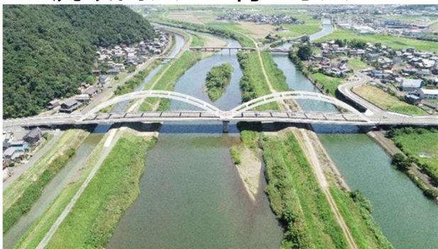
北川下流部(水取地区付近)
