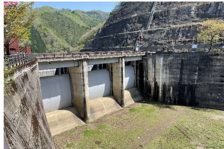
洪水吐きゲートの上流側（令和4年撮影）
