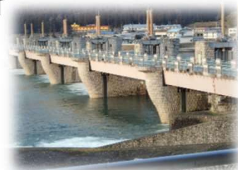
九頭竜川鳴鹿大堰
