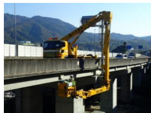
橋梁点検車を用いた点検状況
