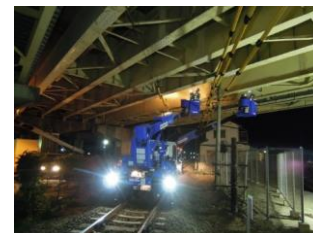
橋梁点検状況(鉄道を跨ぐ橋梁部)
