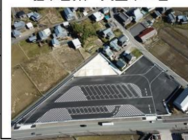
白崎F→着脱場 (R2.3完成) 駐車台数 大型車11台
