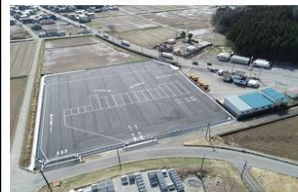
熊坂除雪基地 (R3.3完成) 駐車台数 大型車13台
