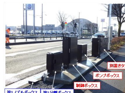
酢酸系液状凍結防止剤散布装置
