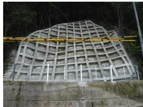
■吹付法枠工対策イメージ
