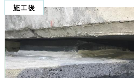
施工後 支承の取替え
