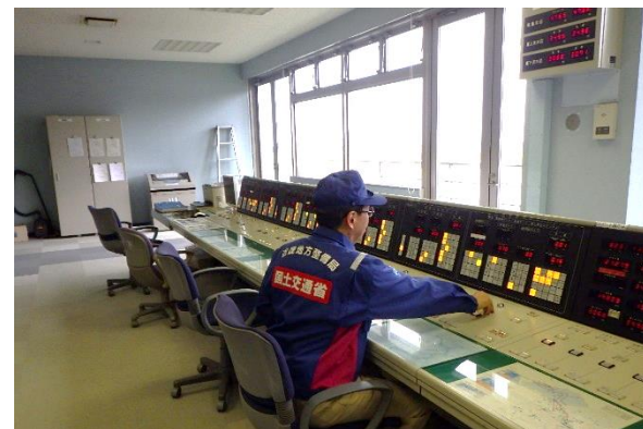
堰の操作システムの点検の様子
