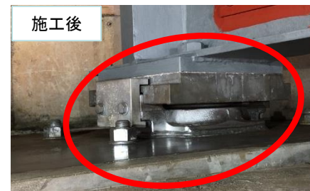
施工後 支承の取替え
