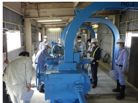
(樋門の操作訓練)
