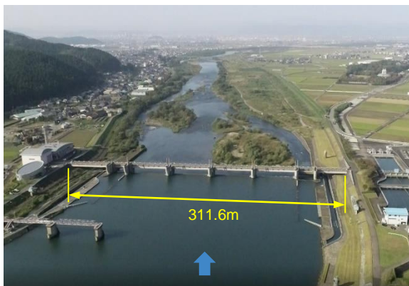
九頭竜川鳴鹿大堰(下流を望む)
