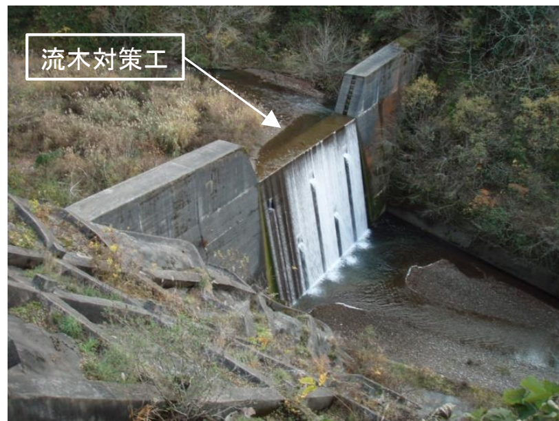
巢原川堰堤改築（流木対策工）
