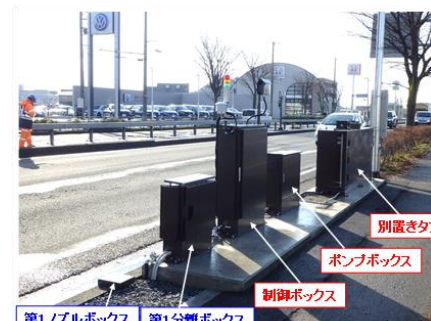
酢酸系液状凍結防止剤散布装置
