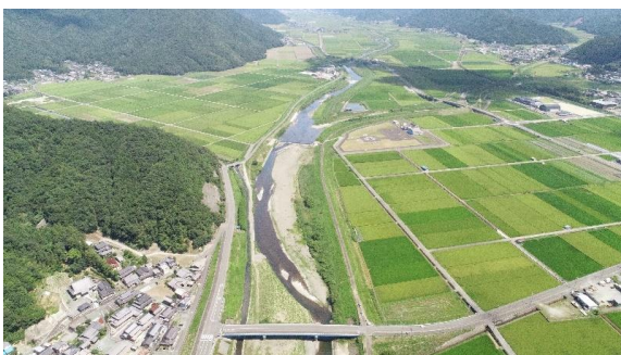
北川中流部(国富・府中頭首工付近)
