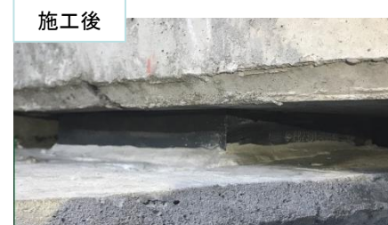
施工後 支承の取替え
