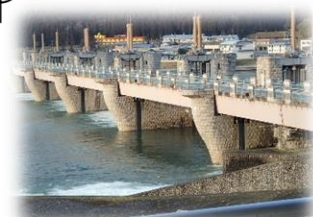
九頭竜川鳴鹿大堰
