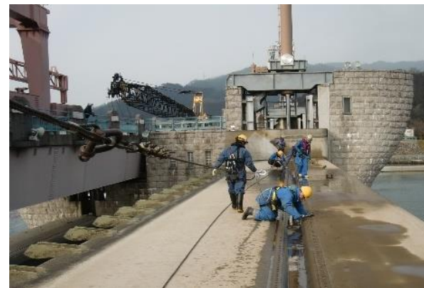
主ゲート扉体点検の様子
