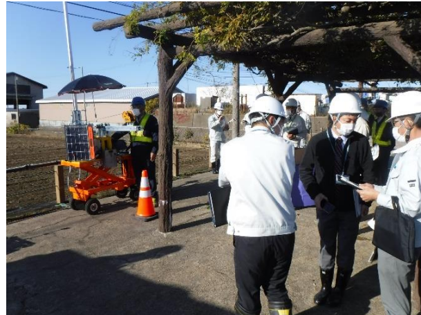
新技術【MCS(マルチカメラシステム)、橋梁点検支援ロボット「見る診るミニ」】を用いた橋梁点検に関する研修 令和4年11月25日開催
