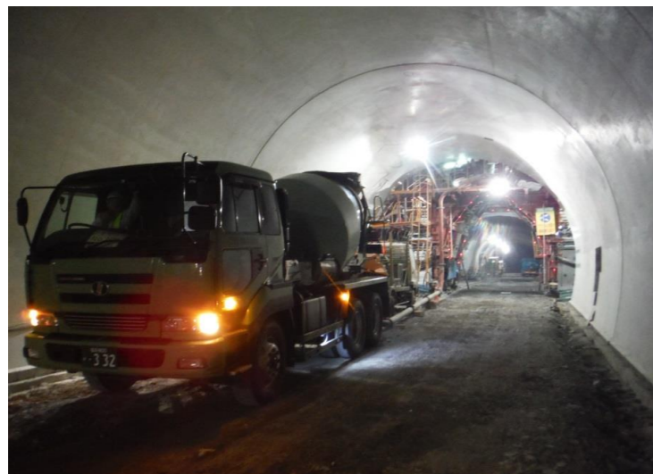
覆工コンクリートの施工状況 (H29.6.30 撮影)
