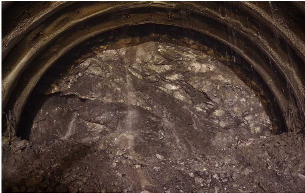
※冠山峠2号トンネル(仮称)は、平成26年6月30日から掘削に着手しました。
