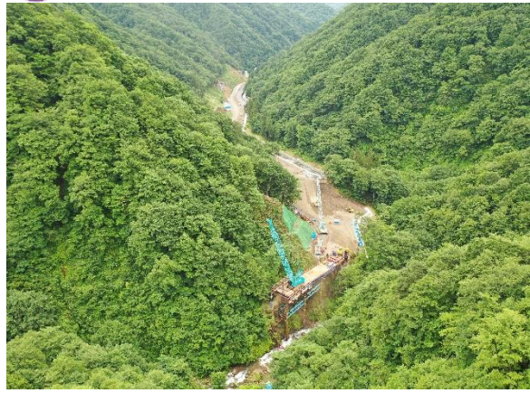
4 5号橋の仮栈橋を設置しています。
