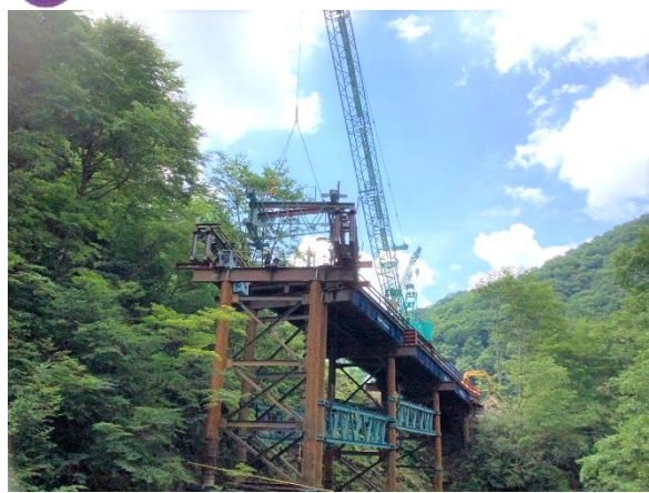
4 5号橋の仮栈橋を設置しています。
