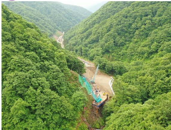
4 5号橋の仮栈橋を設置しています。
