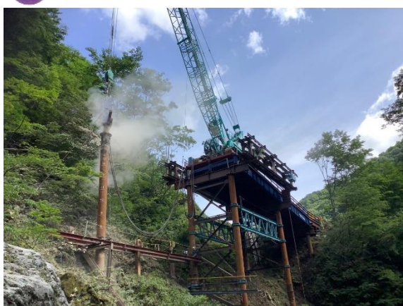
4 5号橋の仮栈橋を設置しています。
