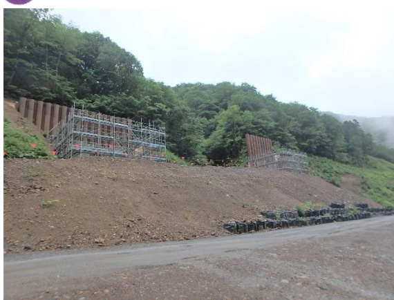
3 3号橋A1・A2橋台の施工状況です。
