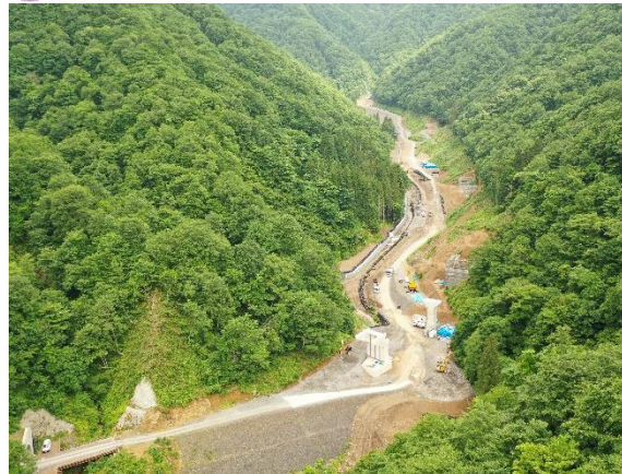
3 3号橋A1・A2橋台の施工状況です。
