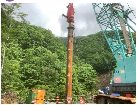
4 5号橋の仮栈橋を設置しています。
