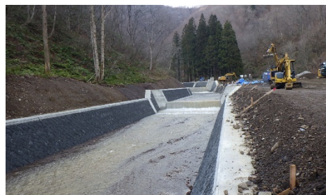
河道付替工事
