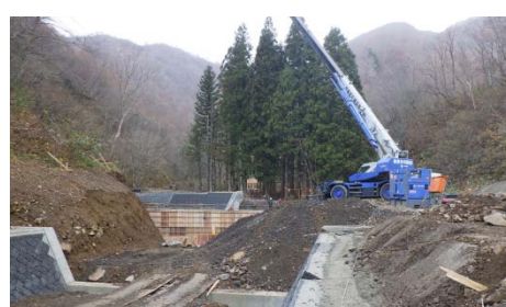
河道付替工事
