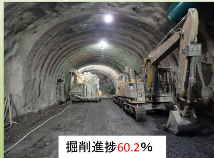
定点写真-② 冠山峠2号トンネル
