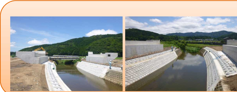
写真-4:熊坂川橋(仮称)東側
