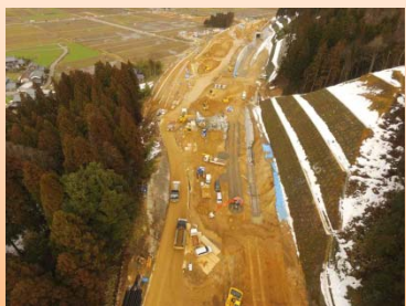
施工状況(浅見地区)
