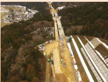
全体の状況(轟2号橋)
