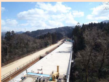
施工状況(轟2号橋)
