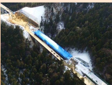
全体の状況(轟3号橋)
