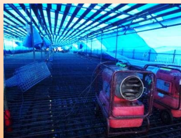
施工状況(轟3号橋)
