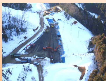
施工状況(光明寺地区)
