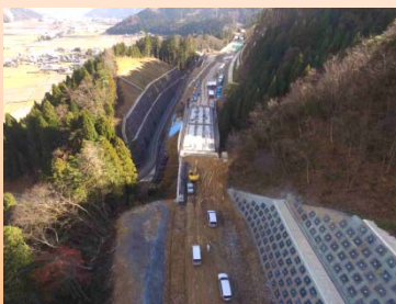
全体の状況(轟1号橋)
