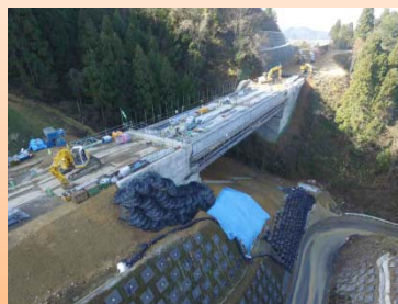
施工状況(轟1号橋)
