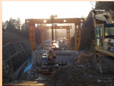
架設状況(轟1号橋)
