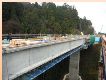
架設状況(轟3号橋)
