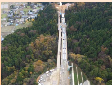
全体の状況(轟2・3号橋)
