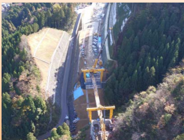
全体の状況(轟1号橋)
