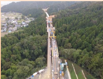
全体の状況(轟2・3号橋)
