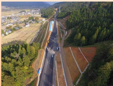
全体の状況(谷口から花谷方面)
