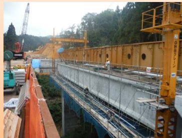
架設状況(轟3号橋)
