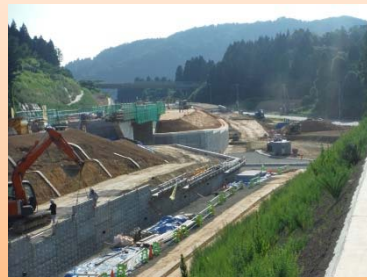
補強土壁施工状況
