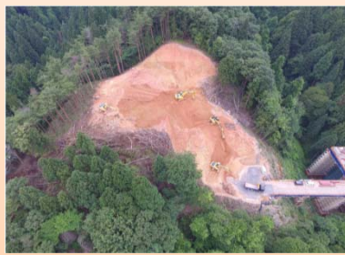
切土区間の状況
