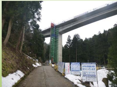
P2橋脚(東側)
