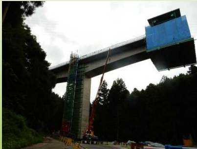
P2橋脚(東側)
