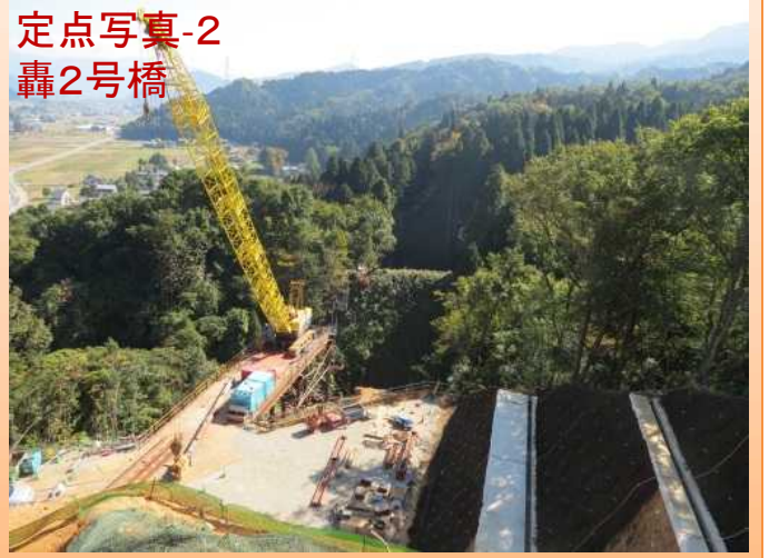
写真-3 道路のり面の崩壊を防ぐ工事を行っています。
