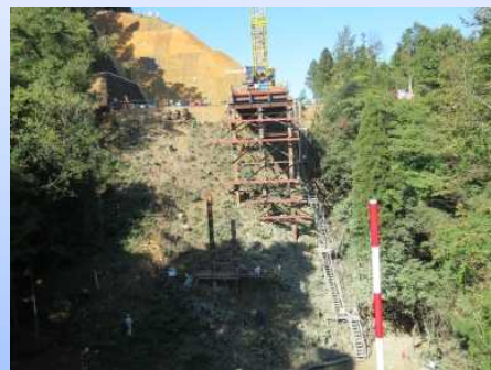
写真-4 急峻な地形に橋梁を架設するため、仮栈橋を作る工事を行っています。
