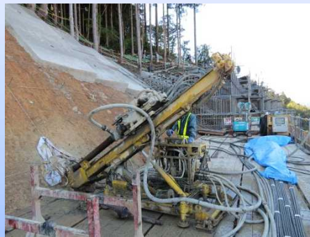
写真-3 道路のり面の崩壊を防ぐ工事を行っています。
