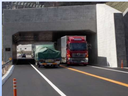
新足田トンネル
