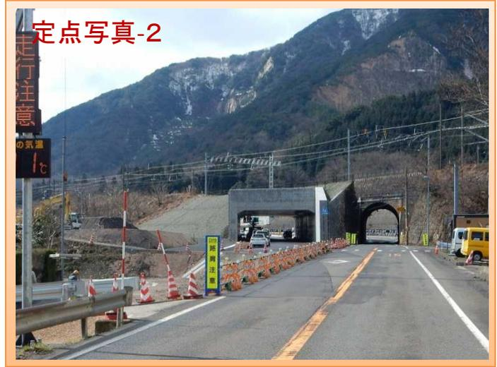
写真-3: 滋賀県側L型擁壁とJR北陸本線との隙間を埋め戻しました。
