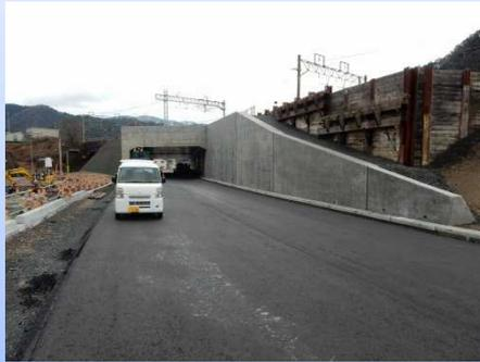
・滋賀県側L型擁壁(長さ約44m)とJR北陸本線との隙間を埋戻しました。
