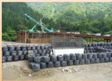
施工状況(P2橋脚)
