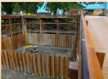
施工状況(P1橋脚)
