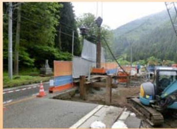
施工状況(P3橋脚)
