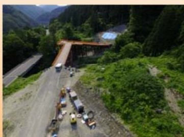
施工状況(下唯野地区)
