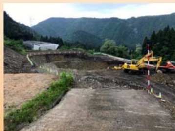
施工状況(西勝原地区)
