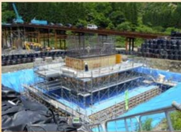
施工状況(P2橋脚)
