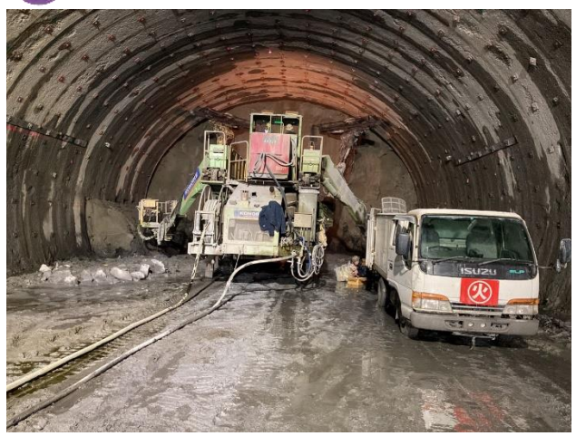
② トンネル坑内の状況です。
