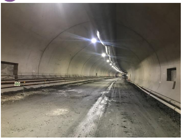
① トンネル坑内の状況です。
