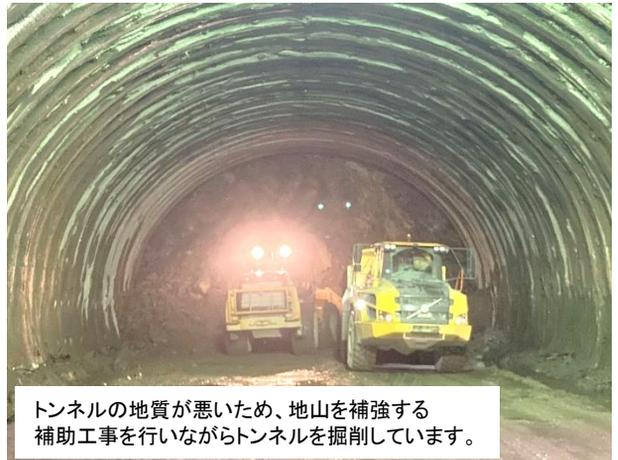
トンネルの地質が悪いため、地山を補強する補助工事を行いながらトンネルを掘削しています。
