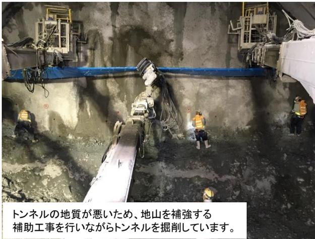
トンネルの地質が悪いため、地山を補強する補助工事を行いながらトンネルを掘削しています。
