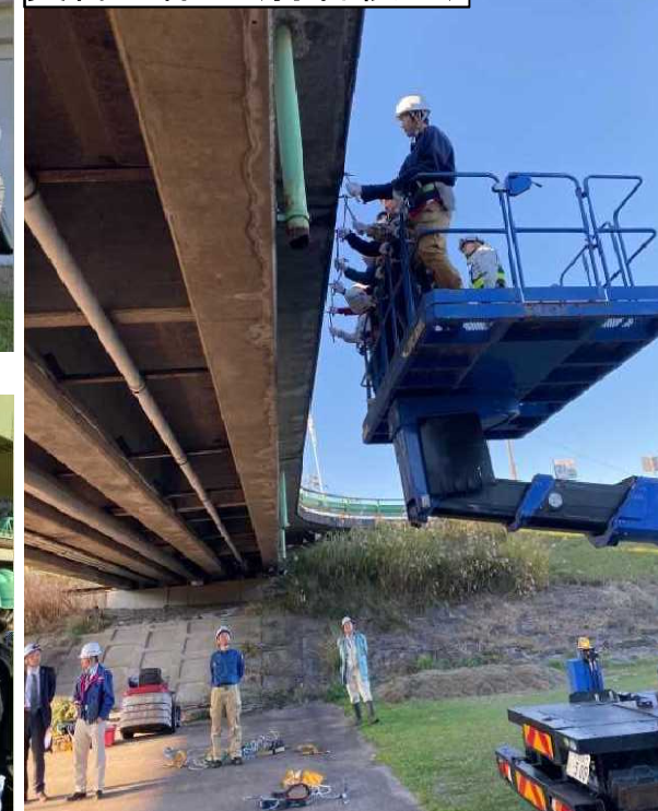
実習の様子(打音検査)
