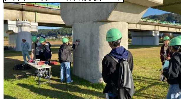
実習の様子(鉄筋探査)
