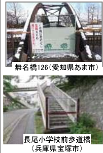
通行止め橋梁
