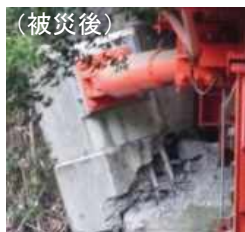
制震ダンパー取付部の損傷
