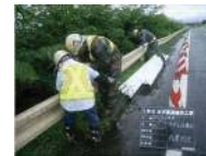
<防護柵の取替>
