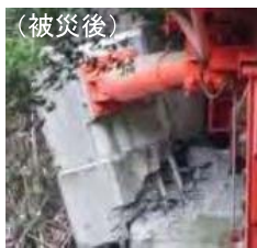
制震ダンパー取付部の損傷
