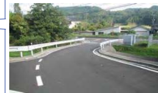
道路の改良(拡幅等)
