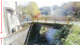
老朽橋の撤去
