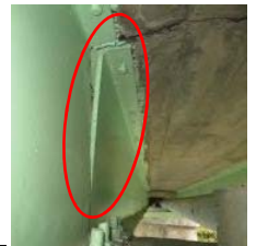
主桁の変形
