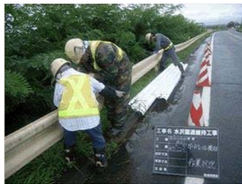
<防護柵の取替>
