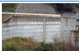
盛土 (補強土壁)
