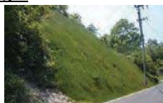
切土 (のり面保護)
