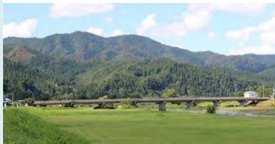
<万石橋の状況>
