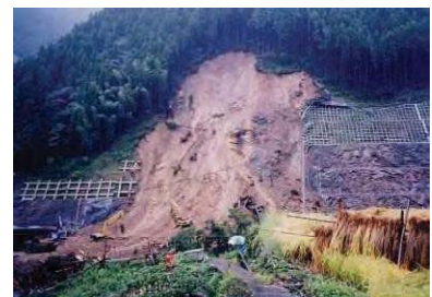
強風化・土砂化斜面での崩壊例
