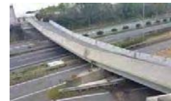
跨道橋の落橋
