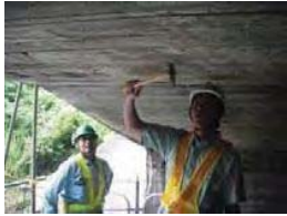
目視及びハンマーによる打音検査
