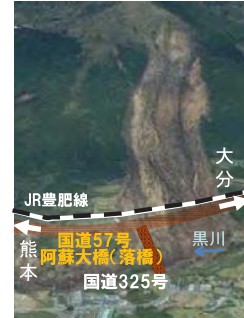
斜面崩落と阿蘇大橋の落橋 (国道57号・国道325号)
