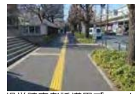
視覚障害者誘導用ブロック
