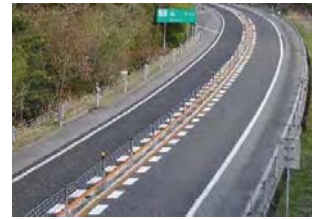
<ワイヤロープの設置事例>
