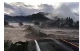
河川氾濫による落橋 (国道274号 北海道日高町千呂露橋)
