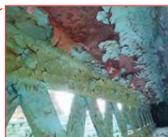
鋼材の腐食
