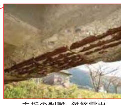
主桁の剥離、鉄筋露出
