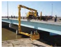
橋梁点検車による点検
