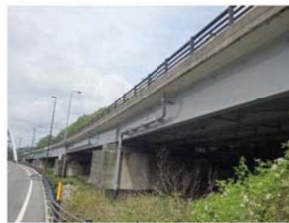
写真-4 阿蘇口大橋 (国道57号)
