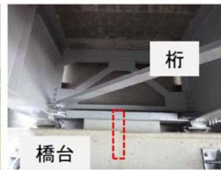
写真-5 アンカーバーのイメージ
