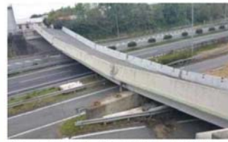
写真-1 県道小川嘉島線 府領第一橋
