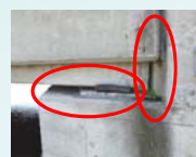
支保交換や桁端点検の空間なし
