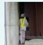
支保交換や桁端点検の空間なし
