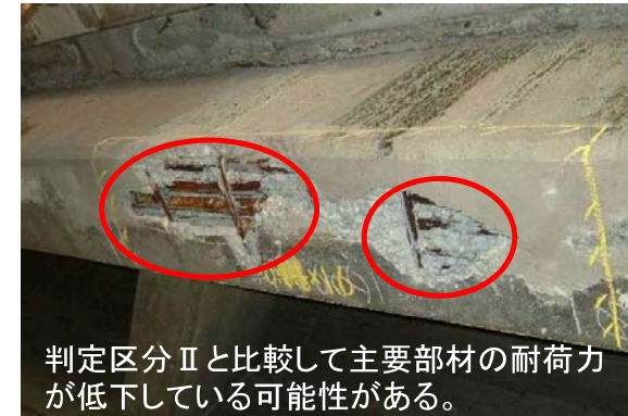
判定区分Ⅲ(主桁の断面欠損)
