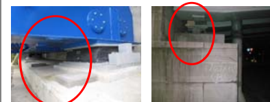
ジャッキアップに配慮した構造
