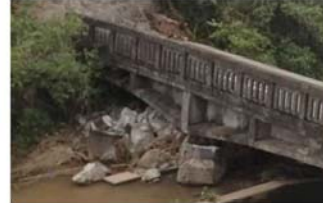
写真-2 平田・小柳線 田中橋
