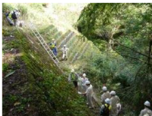
道路防災ドクターによる現地診断
