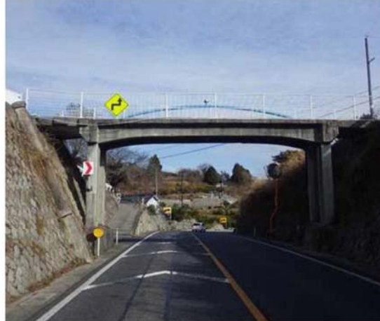
地方管理の跨道橋(未対策)
