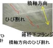
(例) 特殊な形状のPCボステン桁の一部でひび割れが確認されたことを踏まえ、設計基準でひび割れ防止対策を充実
