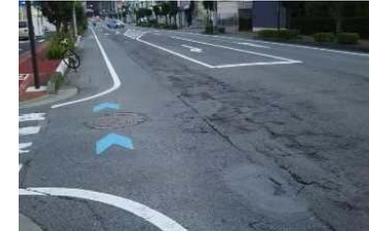
占用工事が起因する路面損傷
