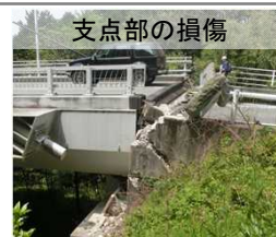
写真-6 熊本高森線 (桑鶴大橋)
