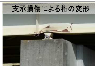
写真-5 九州自動車道 (木山川橋)
