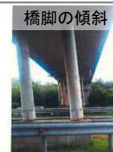
写真-7 九州自動車道を 跨ぐ跨道橋 (神園橋)
