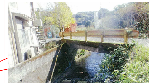
老朽橋の撤去
