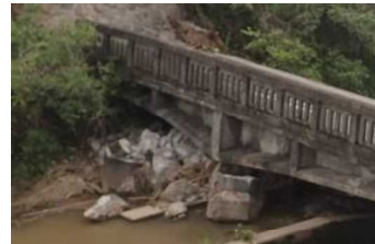
写真-2 平田・小柳線 田中橋
