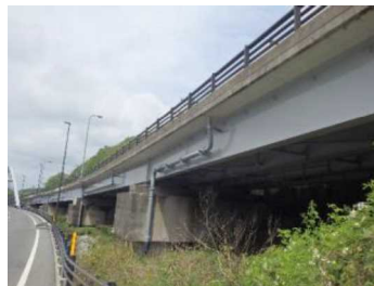
写真-4 阿蘇口大橋 (国道57号)
