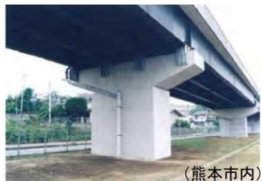
写真-3 国道3号 跨線部
