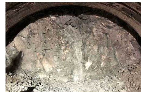
勝原IC側切羽の状況(R3.9: 支保パターンD II)
