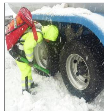
肥料散布機を活用した塩化カルシウムの散布状況
