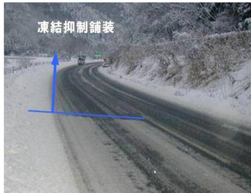
凍結抑制舗装
