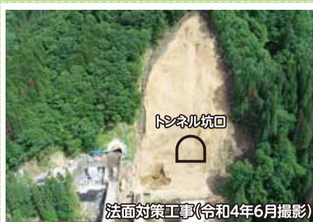
法面対策工事(令和4年6月撮影)
