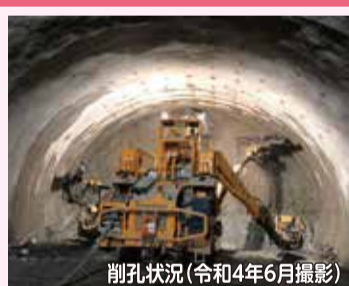
削孔状況(令和4年6月撮影)
