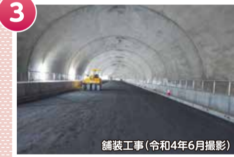
舗装工事(令和4年6月撮影)
