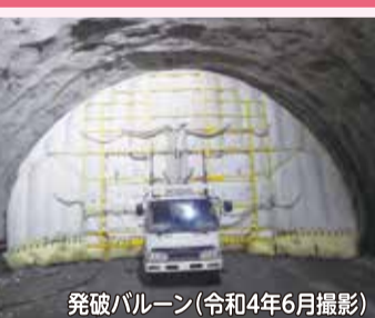
発破バルーン(令和4年6月撮影)
