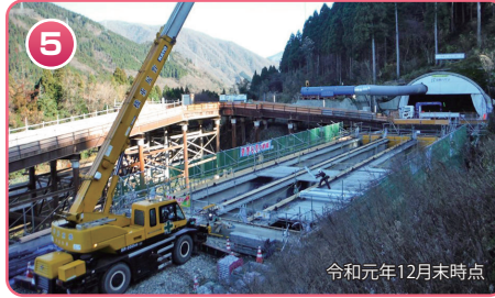
猿ヶ谷橋の上部工事
