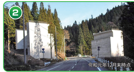
向洞跨道橋の橋梁下部工事
