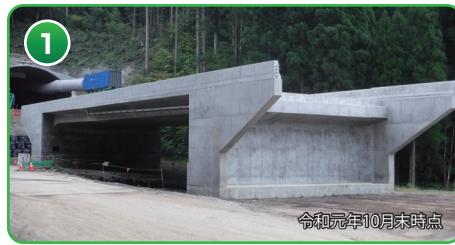
水谷橋の上部工事
