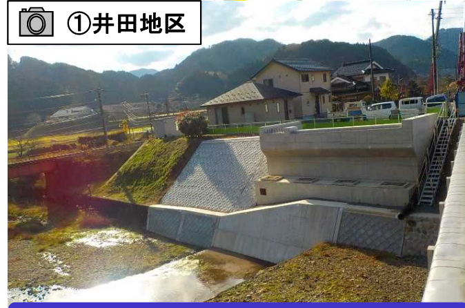
橋台と護岸が完成しました。
