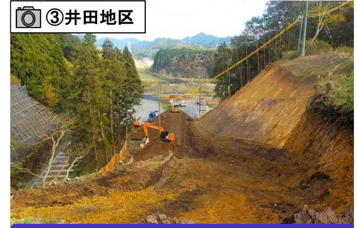
掘削のための工事用道路を整備中です。
