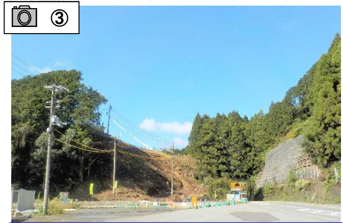
今回工事の伐採完了しました。(掘削準備中です。)
