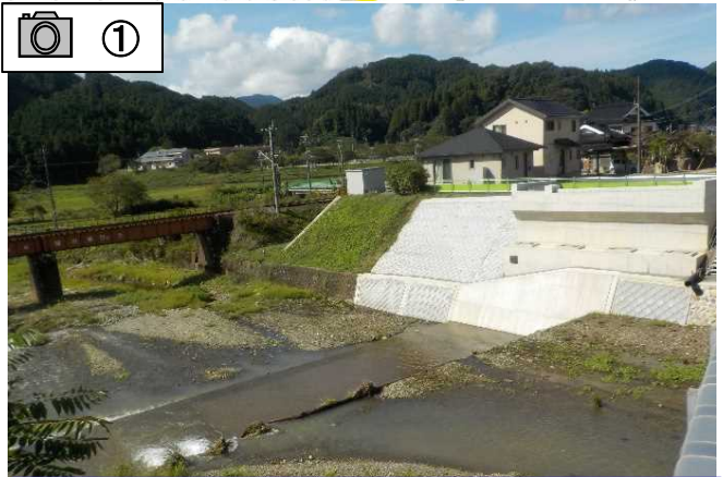
橋台と護岸が完成しました。
