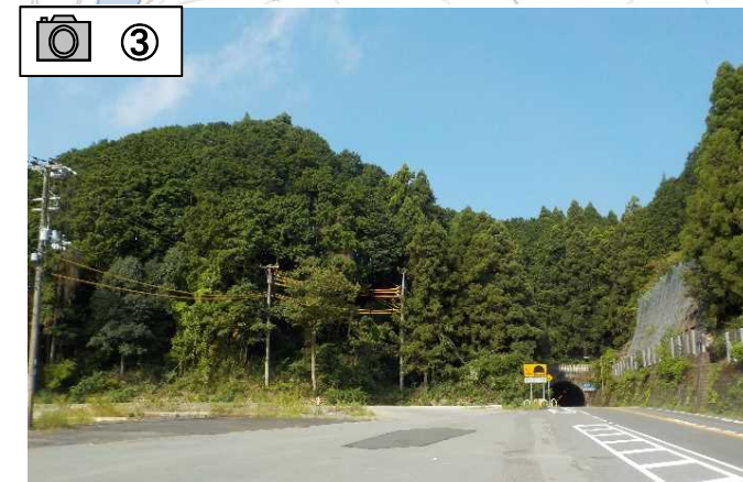
夜久野トンネル東側です。(伐採着手準備中)
