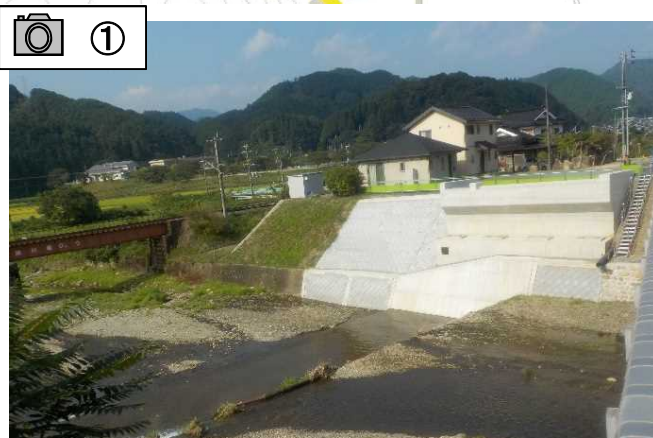
橋台と護岸が完成しました。
