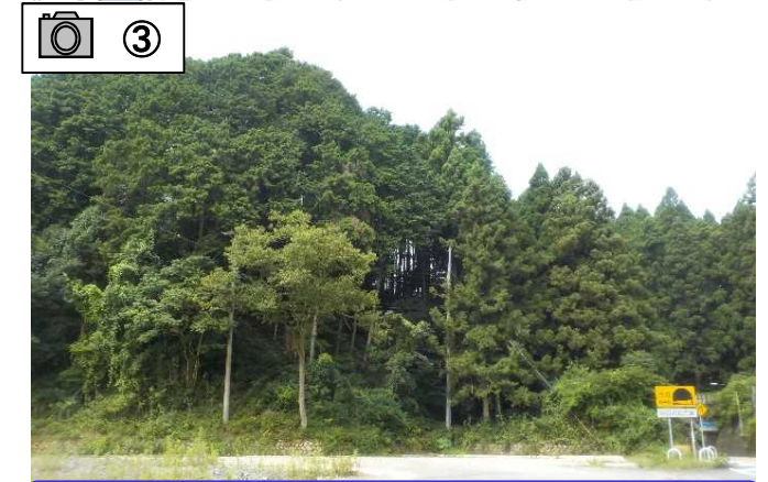
夜久野トンネル東側です。(工事着手準備中)
