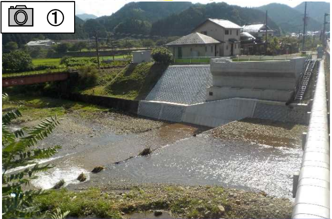
橋台と護岸が完成しました。
