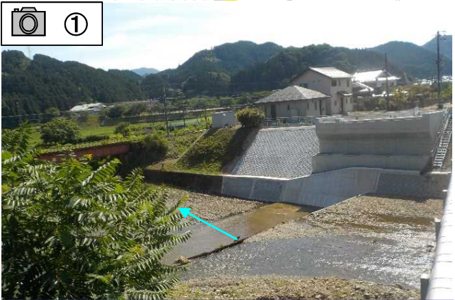
橋台と護岸が完成しました。
